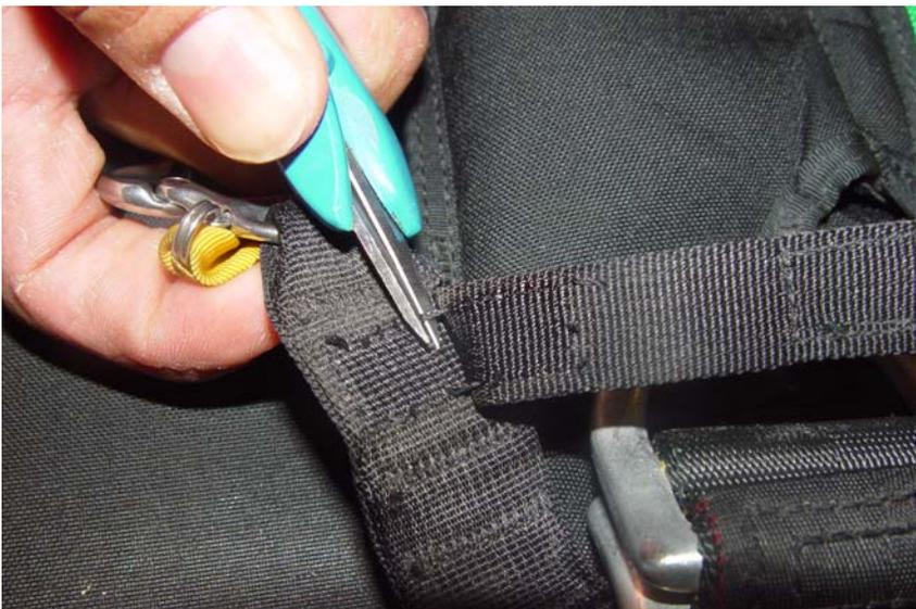
Retirez le velcro du guide du RSL. Ce guide est conçu pour tenir la boule en cristal en place.
